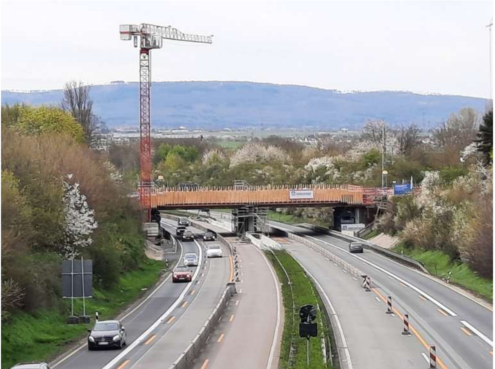
Brückenbaustelle der Main-Weser-Bahn über die A 661 nahe der S-Bahn-Station Frankfurter Berg im April 2023 (Foto: Thomas Kraft)
