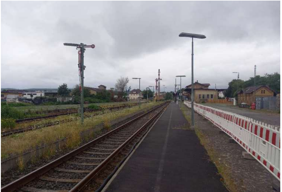
Der Bahnhof Fritzlar unmittelbar vor der Sperrung der Strecke
