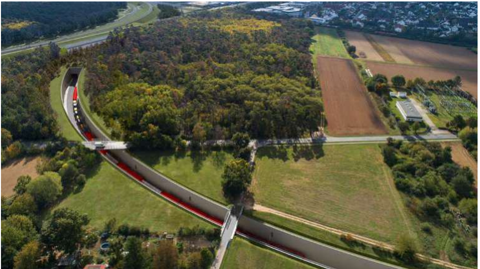
Visualisierung der Weiterstädter SGV-Verbindungskurve in Troglage kurz vor Ein- oder Ausmündung an NBS Frankfurt - Mannheim
