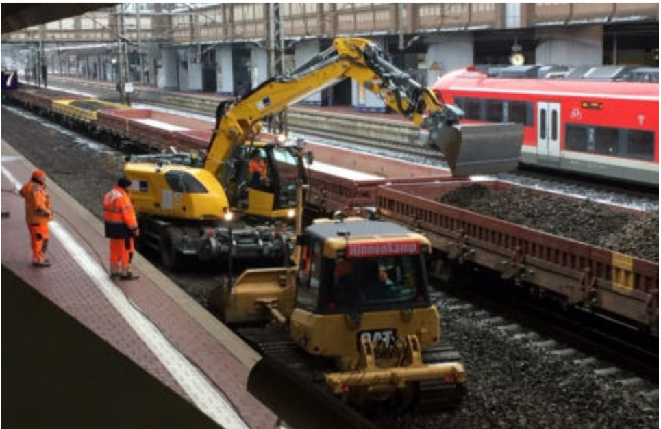
*Vom 2.-4. Dez. 2022 wurde im Bahnhof Kassel-Wilhelmshöhe das Gleis 7 vollständig saniert. Der Neubau erfolgte wieder erhöht gegenüber den Nachbargleisen, um den Einstieg in die RT-Züge zu ermöglichen. Im Hintergrund ein PESA-Triebwagen auf Gleis 4, der in wenigen Minuten als RE17 nach Hagen zurückfahren wird.*
