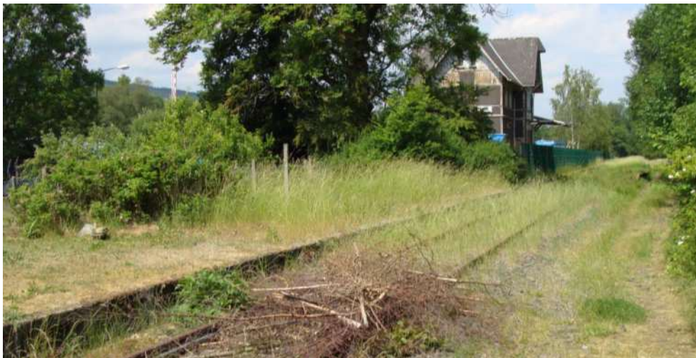
Die Dietzhöhlzalbahn hat, im Gegensatz zur Solmsbachtalbahn, noch Schienen. Hier am Bahnhof Dillenburg-Frohnhausen.
