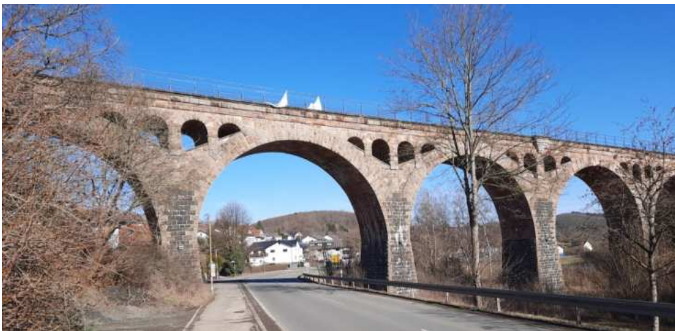
Das Bahnviadukt vor Bad Endbach
