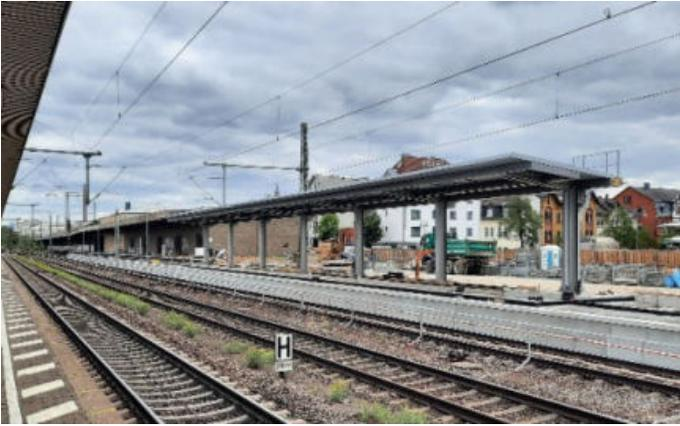
Der Bahnsteig an Gleis 1 wird künftig sogar etwas länger sein, so dass auch Fernzüge dort halten können. Ein neues Dach für einen Teilabschnitt ist im Bau. Dafür fallen alte Bahnanlagen weg, wie man an dem zurückgesetzten Gebäudebestand im Hintergrund sieht.
