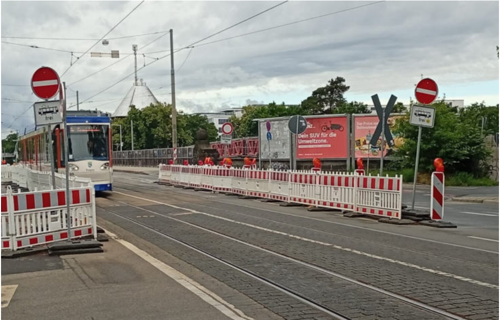
Der derzeitige für Kfz. gesperrte Zustand der Brücke, Blickrichtung nach Westen (Foto: Bernd Rohrmann)
