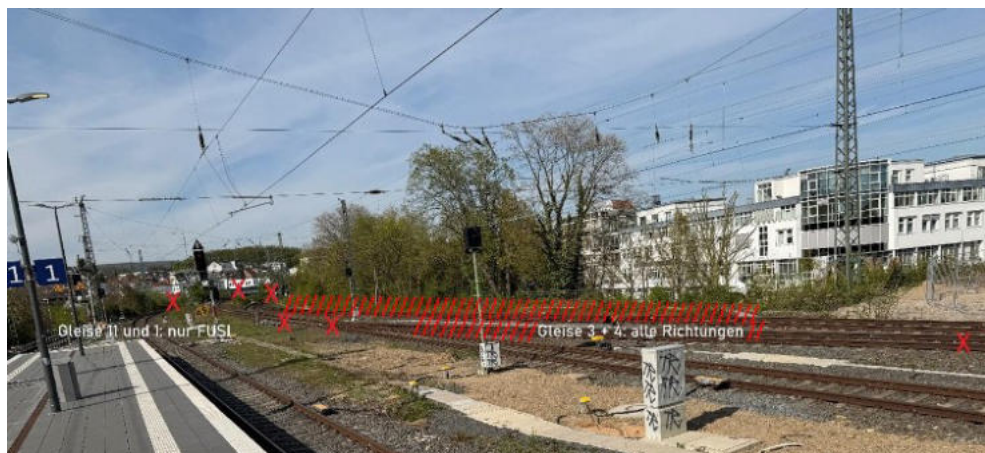
Abb. 5: Bahnhof Friedrichsdorf: Die sechs mit X markierten Weichen des nördlichen Gleisfeldes sollten nach Vorschlag des Stadtplanungsamtes 2011 zurückgebaut und Bahnsteigkanten eingekürzt werden. Die mit ///// markierten Gleise sollten 2011 entfernt werden. (Alle Fotos: Thomas Seibold)
