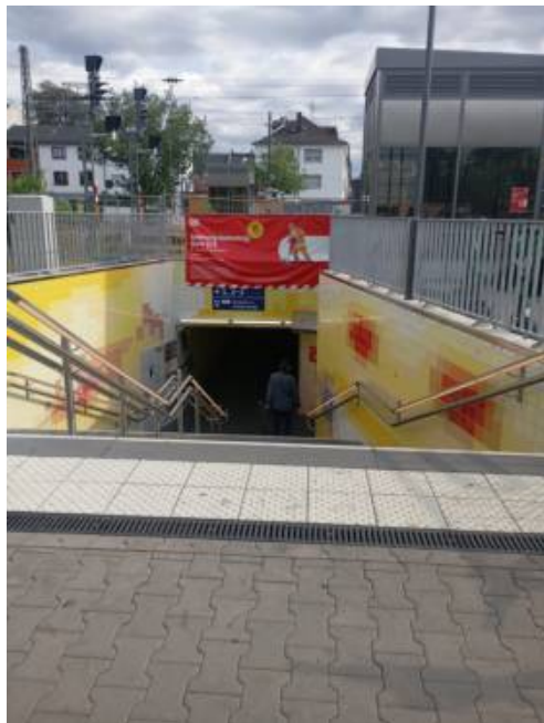
Griesheim: Abgang zur Unterführung mit Metallgeländern
