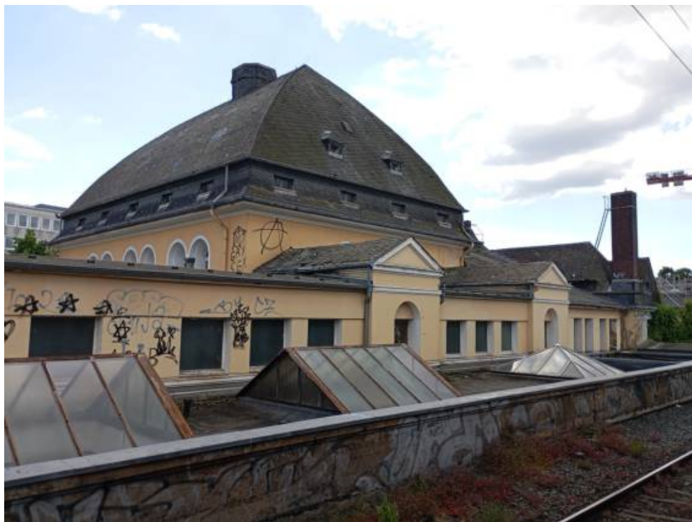
Bahnhof Höchst – das Empfangsgebäude von außen (Bilder von 2025)
