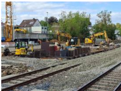
Bild links: Tiefbauarbeiten für den Zugang zum neuen Mittelbahnsteig Gleise 2 und 3. Bild rechts: Die noch nicht komplett abgebrochene Zugangsanlage im Bereich Hausbahnsteig Gleis 1. (Foto: Werner Filzinger)
