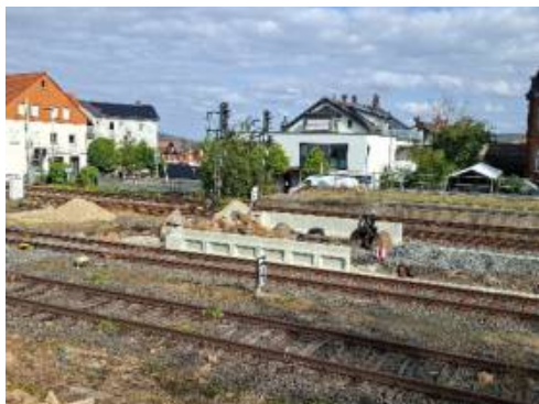
Bild links: Der neue Bahnsteig ist in ersten Ansätzen mit Kantensteinen zu sehen. Bild rechts: Die Absperrung zur Unterführung in der Bahnhofshalle. (Foto: Werner Filzinger)
