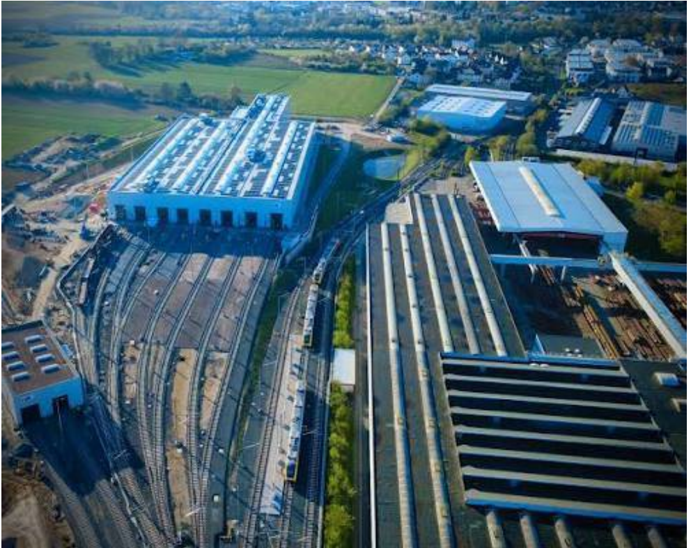
Die neue Instandhaltungsanlage der HLB in Butzbach aus der Luft, rechts das Weichenbauwerk und ganz oben am Bildrand die Main-Weser-Bahn. (Bildherkunft: Hessische Landesbahn)
