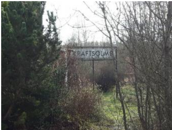
Die Außenfläche des früheren Bahnhofsgebäudes im Waldsolms' Ortsteil Kraftsolms ist stark bewachsen. Das alte Bahnhofsschild steht auf dem früheren Hausbahnsteig. (Bild: Thomas Kraft)
