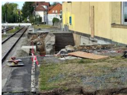
Bild links: Tiefbauarbeiten für den Zugang zum neuen Mittelbahnsteig Gleise 2 und 3. Bild rechts: Die noch nicht komplett abgebrochene Zugangsanlage im Bereich Hausbahnsteig Gleis 1. (Foto: Werner Filzinger)
