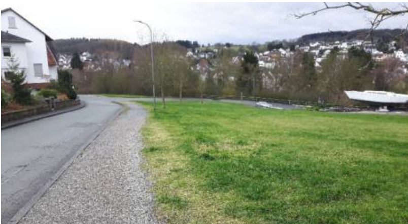
Der zugeschüttete Bereich der südlichen Einfahrt der Solmsbachtalbahn in den Burgsolmser Tunnel zwischen den Straßen Tunnelweg und Taunusblick im Solmser Stadtteil Burgsolms (Bild: Lars Möbius)
